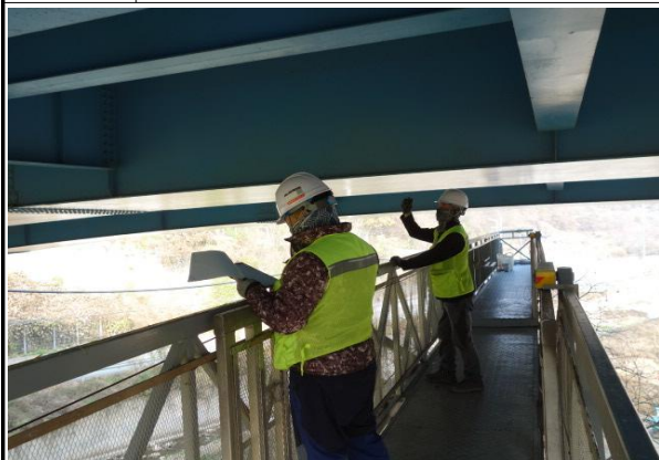
위 치 SLAB 하면
