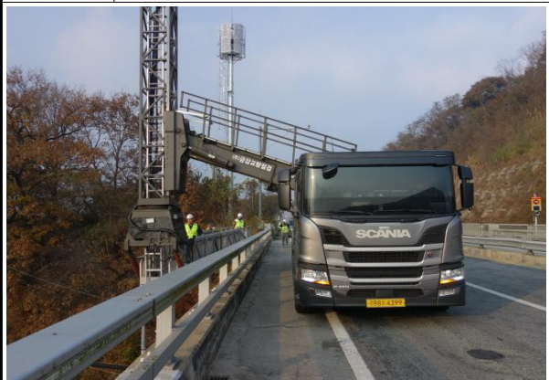
위 치 SLAB 상면
